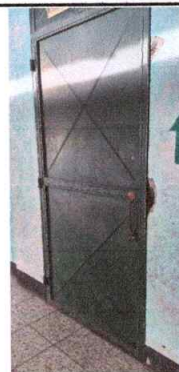
Foto 2: Puerta de Metal. 4.3: Sustitución de Puertas, Módulo de Aula 1
