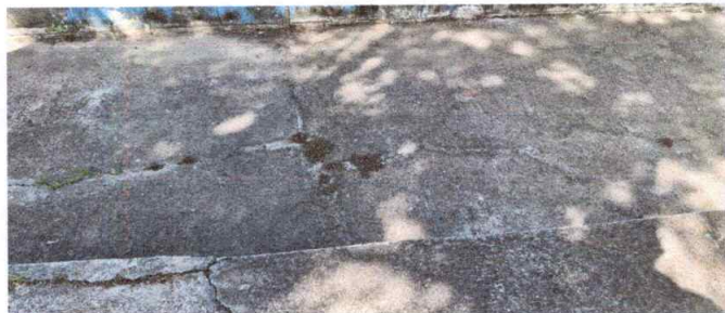
FOTO 7: Loza de Patio. Reparación de planchas de concreto de patio, Módulo de Servicios Sanitarios
