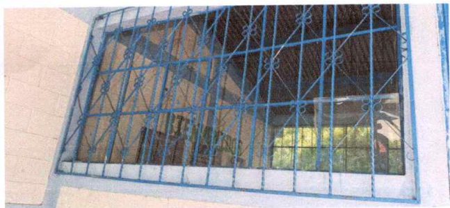
Foto 3: Ventanas. Sustitución de balcones de metal, Módulo de Aula 2
