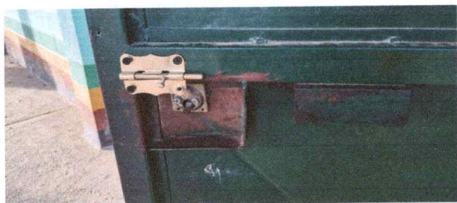
Foto1: Puerta de Metal. Sustitución de chapas, Módulo de Aulas 1 & 2
