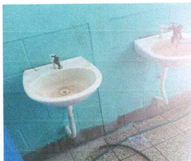
Foto 5: Servicios Sanitarios y sus Accesorios. Sustitución de pedestales de lavamanos, Módulo de Servicios Sanitarios
