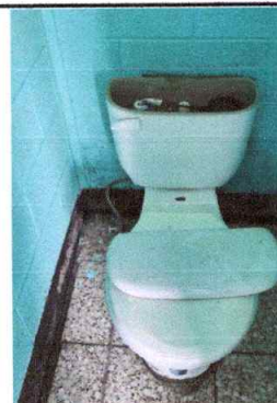
Foto 4: Servicios Sanitarios y sus Accesorios. Sustitución de inodoros, Módulo de Servicios Sanitarios
