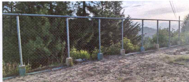
FOTO 8: Muros Perimetrales. Reparación de Muro perimetral de Blok, Áreas Comunes
