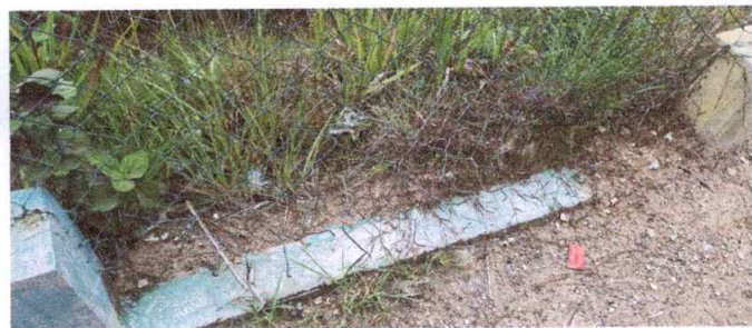
FOTO 9: Muros Perimetrales. Reparación de malla, Áreas Comunes
