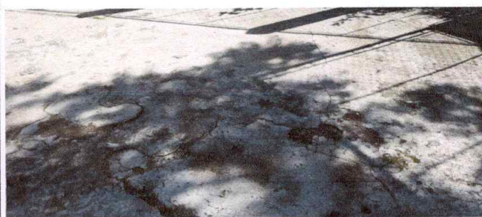
FOTO 10: Losa de Patio. Reparación de planchas de concreto de patio. Áreas Comunes.
